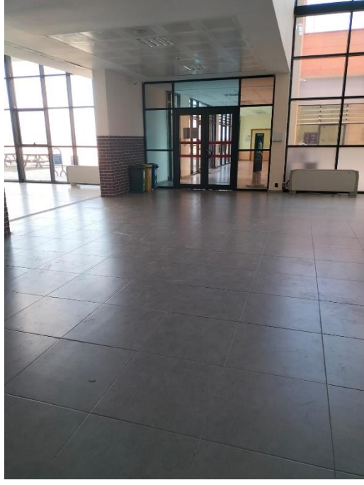
Şekil 29. Görme Engelliler için Zemin İyileştirilmesinin Olmaması ve Ara Kapıların Tekerlekli Sandalye Kullanımında Açma Güçlüğü
